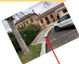
Prévoir un arrondissement de l'angle du muret sur l'accès à la Mairie
