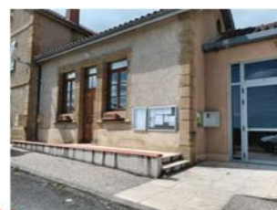
Mairie : Rampe d'accès réalisée en 2015/2016 : 24 957,49€
