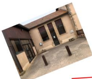
Salle des Fêtes et Mairie : Accès et place PMR réalisé en 2011/2017 et 2018 : 30 236€
