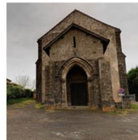
Eglise : Création de place PMR en 2016 Rafraichissement peinture au sol de la place PMR
