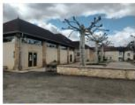
MAIRIE : Place PMR non signalée
