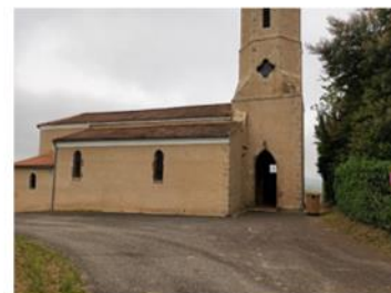
Eglise et Cimetière : Accès et place PMR réalisé en 2020 Rafranchissement peinture place PMR
