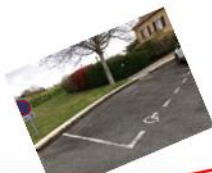
Mairie, Salle des Fêtes : Création de place PMR, Accès à la Mairie et à la Salle des Fêtes, Réalisation faite en 2005 Rafraîchissement de la peinture de la place PMR
